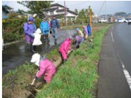
側溝の泥上げ
