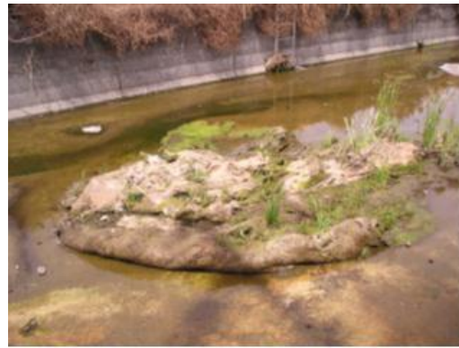
土砂の堆積状況
