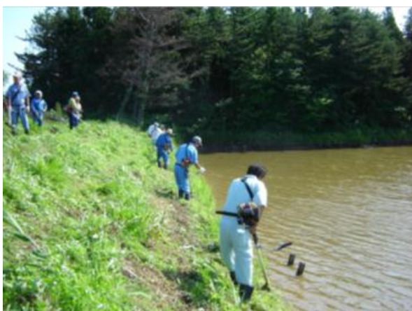
ため池堤体の草刈り
